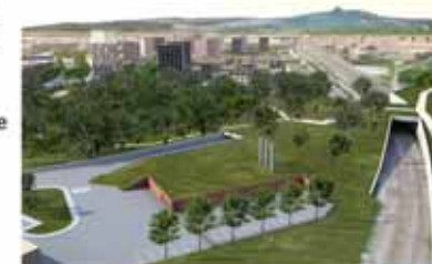
vista dalla centrale di cogenerazione
