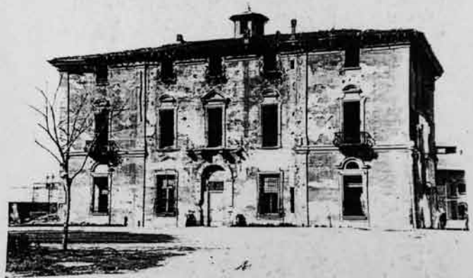
Tav. 201 - La Villa Farinelli a Bologna, prima della demolizione (1948).
